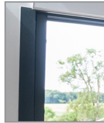
LIGNE INTÉRIEURE moderne à angles droits
