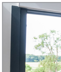
LIGNE INTÉRIEURE moderne à angles droits
