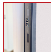
GÂCHE ÉLECTRIQUE (À RUPTURE, À ÉMISSION OU JOURNALIÈRE)
